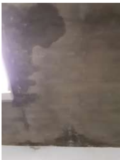
b- Filtración de agua en columnas de bajada
